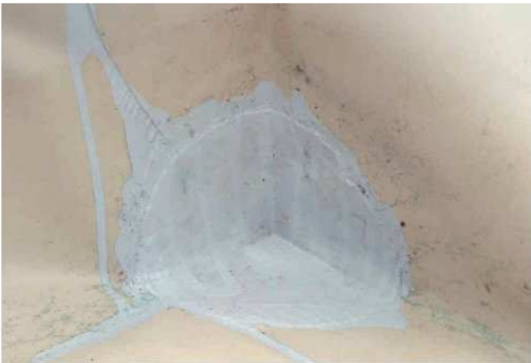
Abb. 4: Eckverstärkung mit vorgefertigten Formteilen
