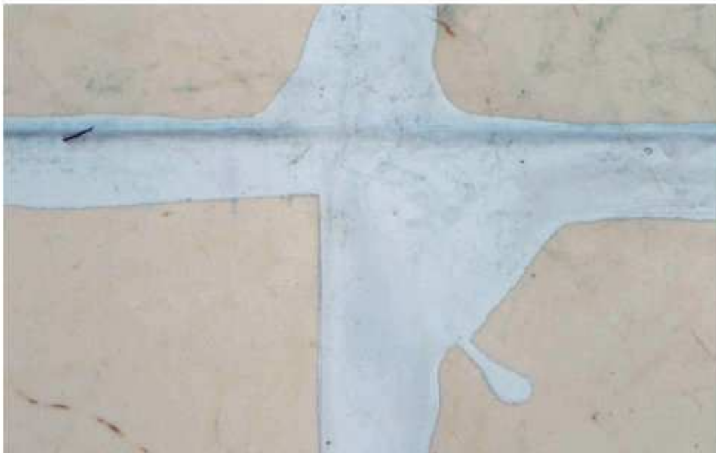
Abb. 2: Bahnoberseite mit T-Stoß
