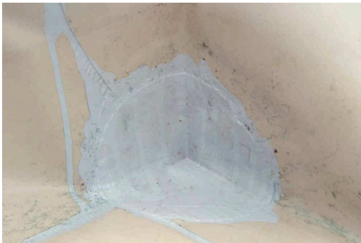
obr. 4: zesílení rohu předvyrobenými výlisky
